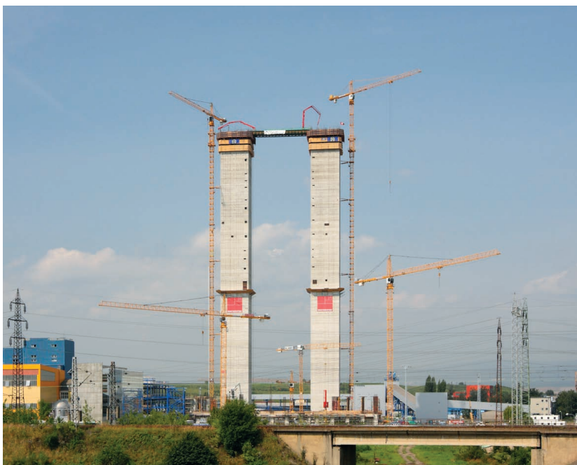
Mezi dvě betonové věže se namontuje ocelová konstrukce a vlastní kotelna
