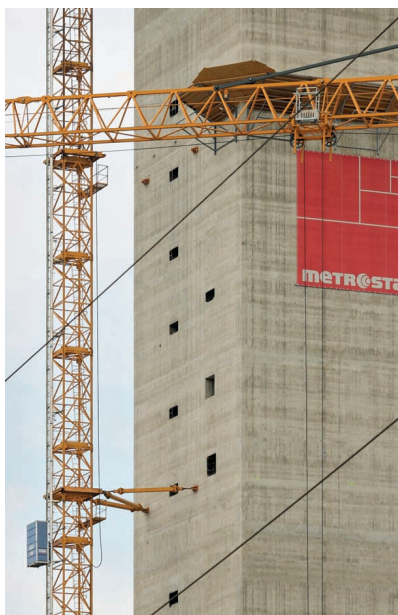
S ohledem na nadstandardní výšky háků u jeřábů 4 a 5 je firma Kranimex dovybavila personálními výtahy GEDA
